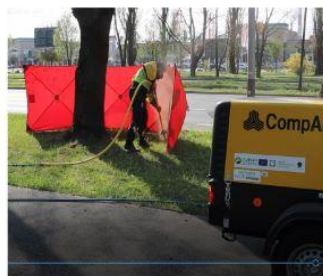
Rys. 6. Napowietrzanie gleby w pasach drogowych
