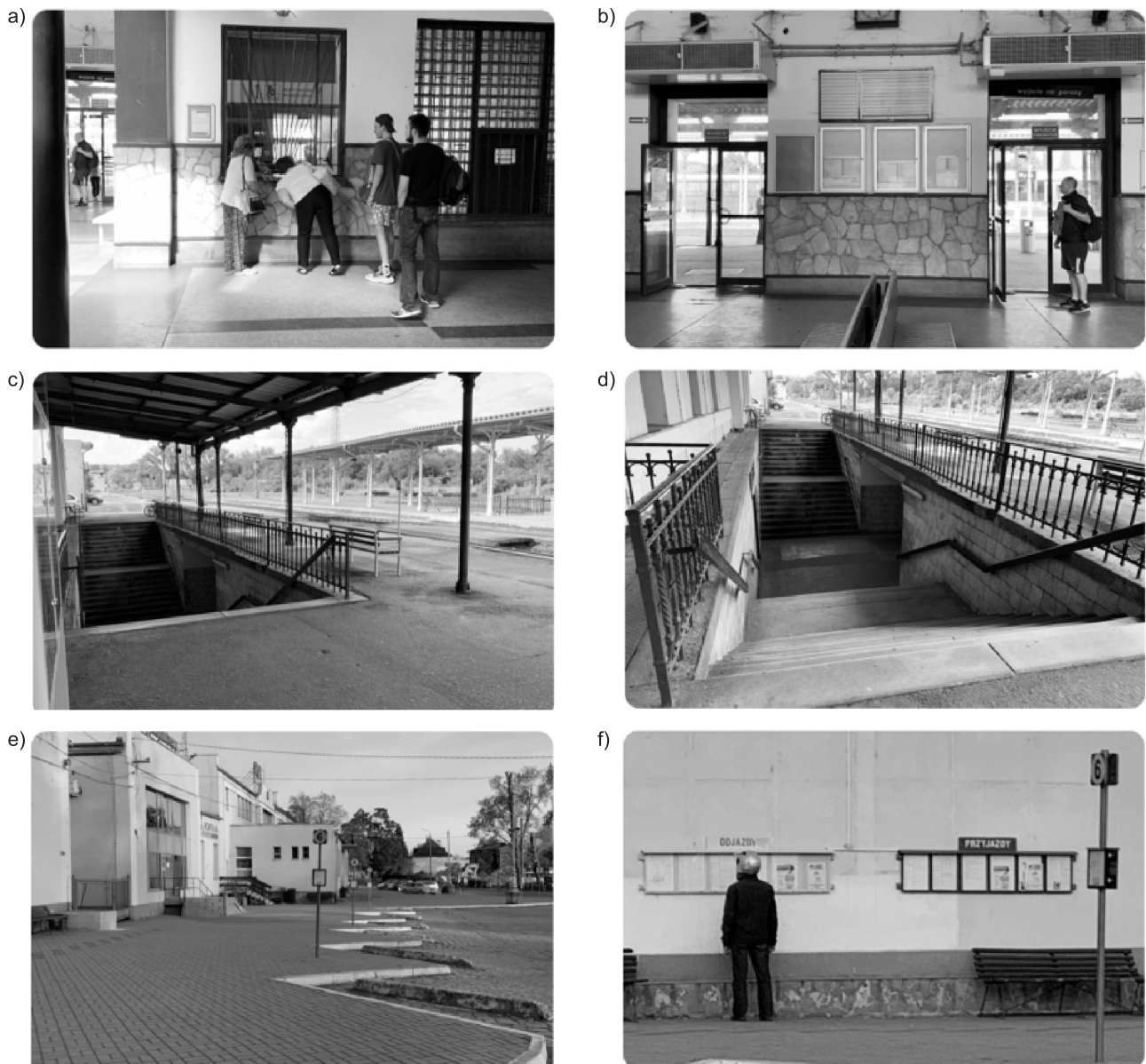
Rys. 7. Nyski węzeł multimodalny – stan lipiec 2019 r.; obiekty na dworcu kolejowym: a) kasa biletowa, b) informacja pasażerska, c) standard peronu, d) przejście na perony; obiekty na dworcu autobusowym: e) główne wejście, perony, f) informacja pasażerska [fot. autorów]
